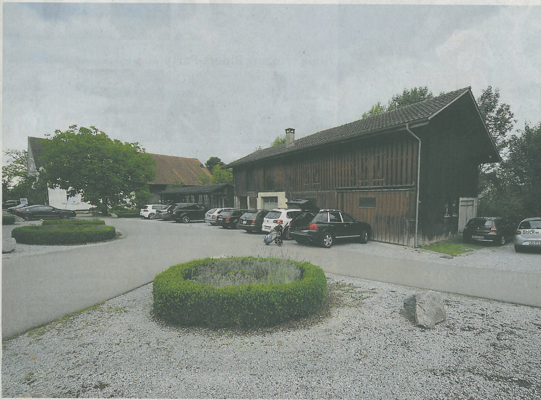
Auf dem Rossberg dürfen einzelne Gebäude abgerissen und Mehrfamilienhäuser mit 18 Wohnungen gebaut werden, obwohl der Weiler in einer Kernzone liegt. Bild: Heinz Diener
